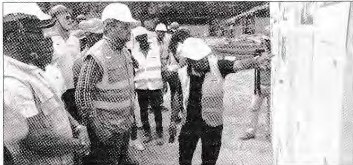
Lancement des travaux d'infrastructures dans le cadre du projet Volobe II.
